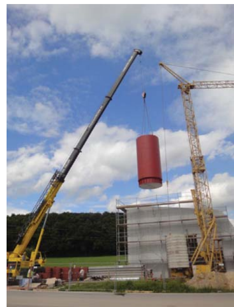
Einbau des Pufferspeichers per Kran
