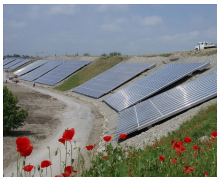
Illustration 2 : Sur une pente (Schüco), Crailsheim, Allemagne (par Stadtwerke Crailsheim GMBH). Noter la taille comparée à la voiture en haut et à l'homme en bas. [1], Fiche action 2.2
